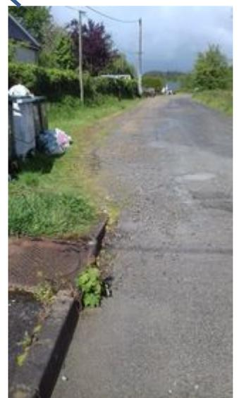
Voie non enrobée, bas-côtés non entretenus, absence de trottoirs, multiples nids-de-poule, évacuation des eaux pluviales problématique, fourreaux de raccordement qui posent question... ce que j'ai pu voir moi même sur le terrain va tout à fait dans le sens des éléments fournis au dossier d'enquête et est
